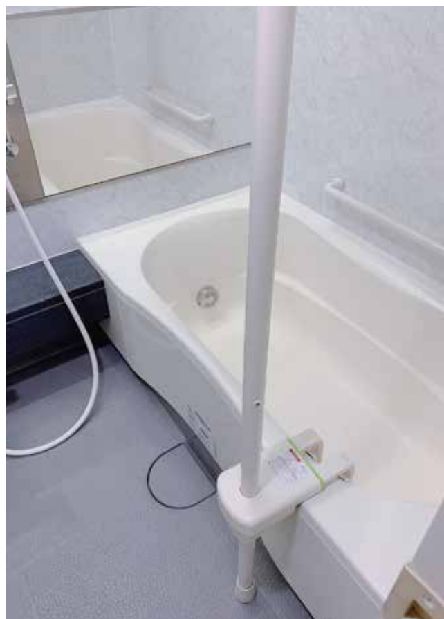
浴槽縁の幅の幅違い（大）
