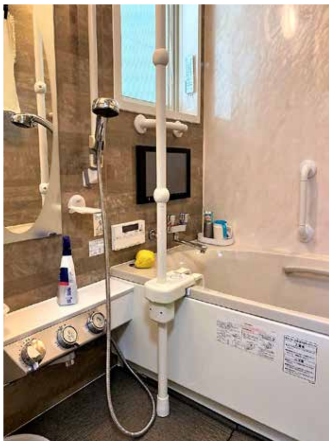
エプロンに強度がない浴槽
